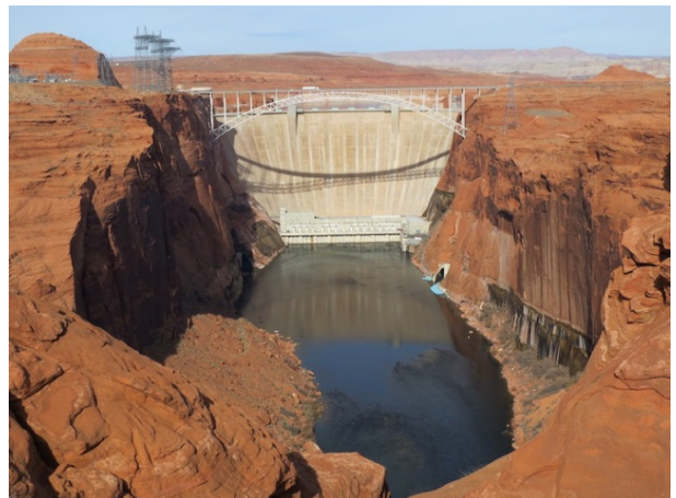
図 18 グレンキャニオンダム。コロラド川をせき止めてパウエル湖（Lake Powell）をつくっている。ダム手前のアーチ橋は国道 89 号線。
